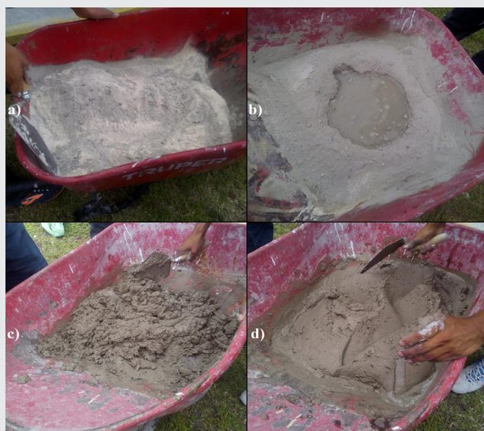
Figura 4. Obtención de la mezcla: a) Mezclado de arena, polvo de mármol y cemento; b) Vertido de agua; c) Mezclado; d) Mezcla homogénea obtenida.
