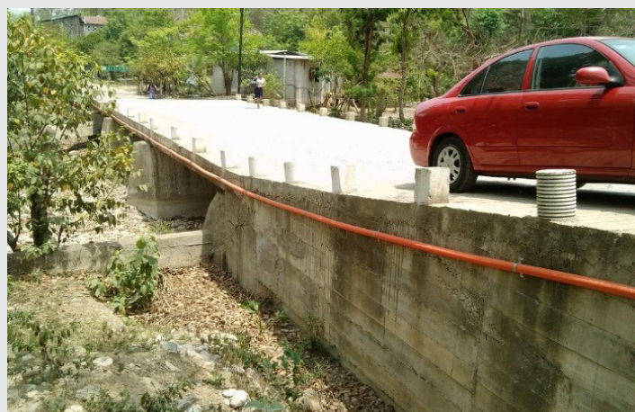
Figura 2. Despliegue de cable de fibra óptica a través de un puente en carretera Tamazunchale Mecatlán.
