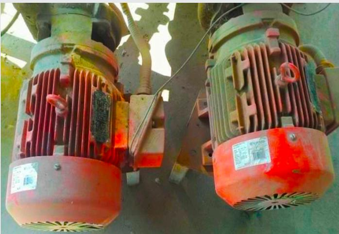
Fig. 11. Bombas de agua para el chiller
