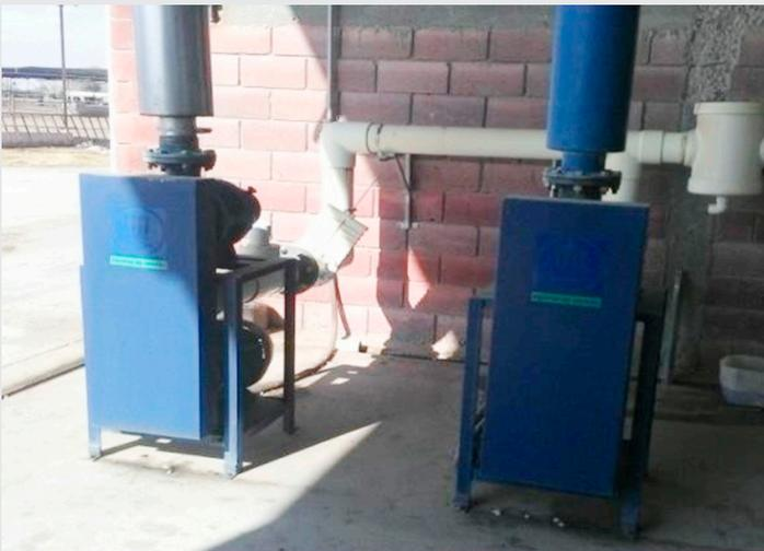
Fig. 10. Bombas de vacío 30 HP cada una
