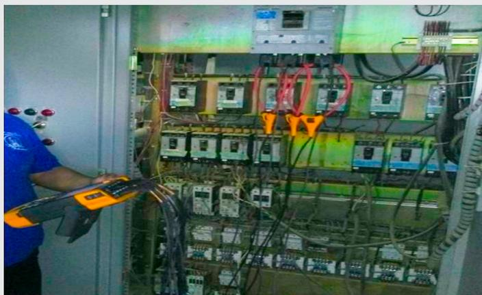
Fig. 14. Mediciones en el centro de carga general
