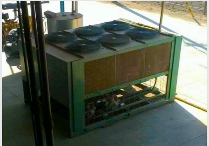
Fig. 12. Compresor del Chiller 30 HP
