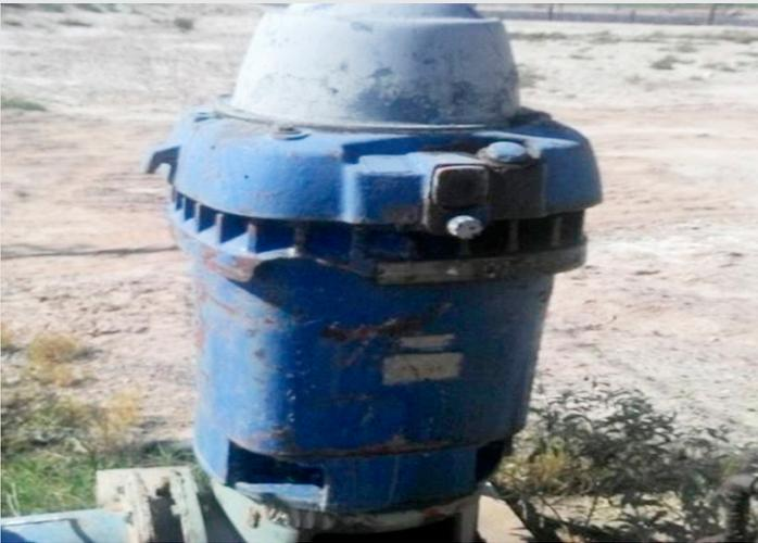
Fig. 9. Bomba No.1 de pozo profundo de 100 HP
