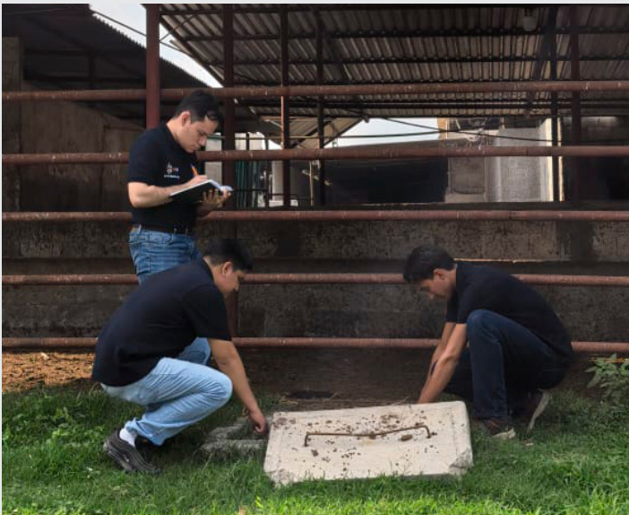
Figura 2. Actividades de campo durante la apertura de la caja de registro para inspección y toma de datos.
