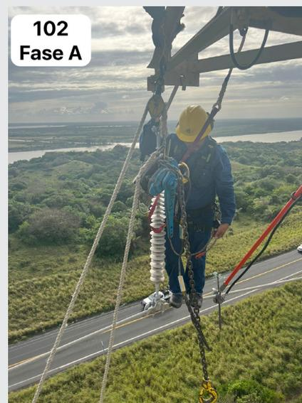
Figura 3 Cambio de Aisladores tipo sintético.
