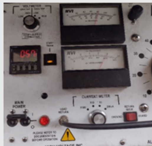
Figura 8. Inyección de voltaje y corriente de fuga durante la prueba dieléctrica a un equipo hidráulico con barrena. Fuente: Elaboración propia.
