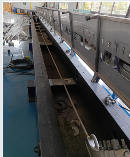
Figura 8. Perspectiva del tendido de la LTs en laboratorio para la prueba de TRN. Fuente: Elaboración propia.
