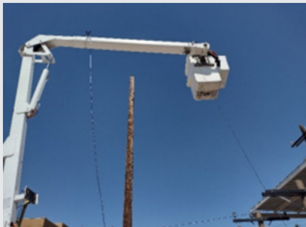
Figura 9. Inyección de voltaje en un brazo aislado para determinar sus propiedades dieléctricas Fuente: Elaboración propia.
