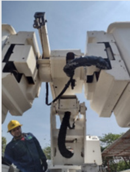
Figura 6. Fuga de aceite hidráulico durante la prueba operativa en un equipo hidráulico de elevación de doble canasta.
