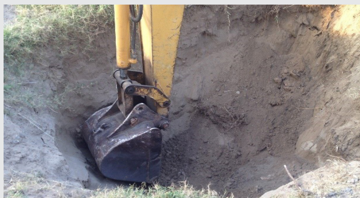
Foto 1. Excavación del pozo de monitoreo del NAF.
