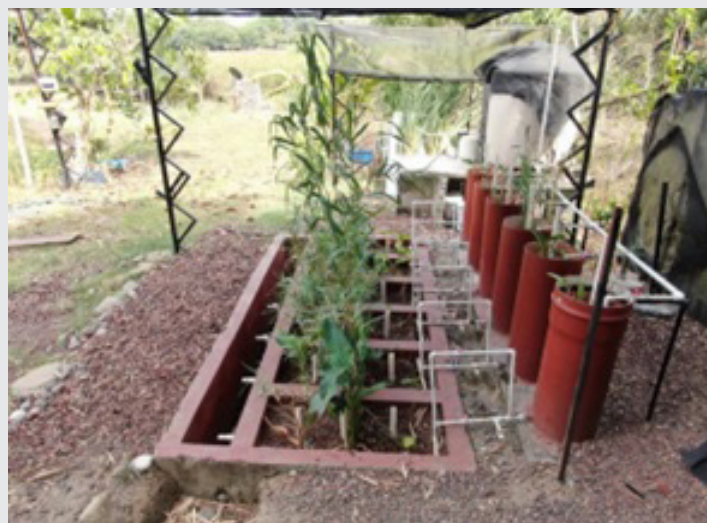
Figura 1 Humedal construido para el tratamiento de aguas residuales contaminadas con BTEX y MTBE del Instituto Tecnológico Superior de Misantla.
