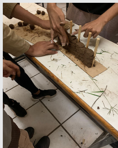
Figura 7. Construcción de muro COB.
