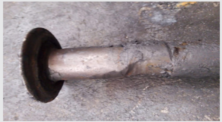
Figura 4. Pernos deformados.
