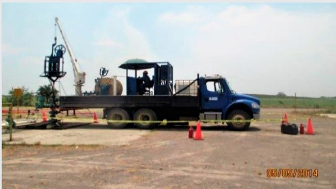
Figura 5. Instalación de tubería capilar (Fuente: Empresa paraestatal, 2018)
