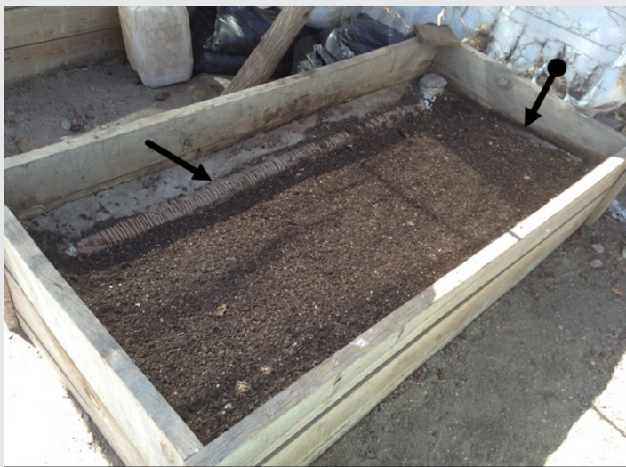
Figura 2. Cama construida para la recolección de lixiviados. Tubo recolector (flecha normal) y ligera inclinación al tubo recolector (flecha con inicio ovalado).
