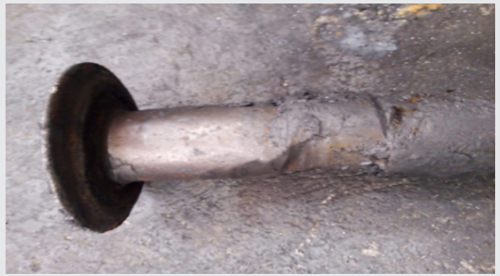
Figura 4. Pernos deformados.
